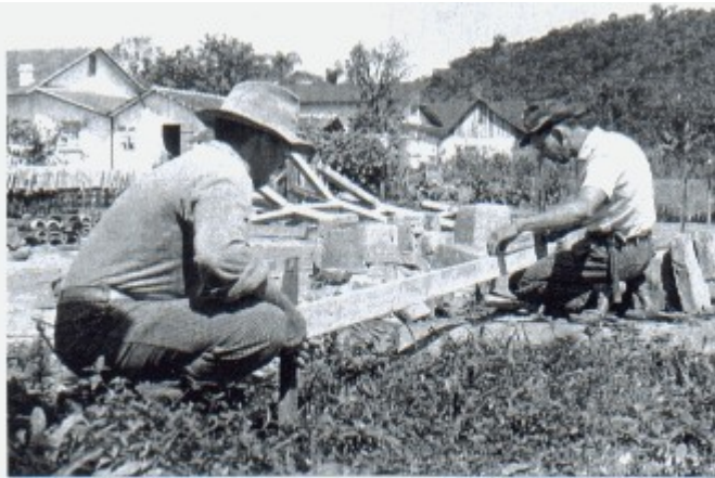
Medindo o Fundamento da futura igreja
